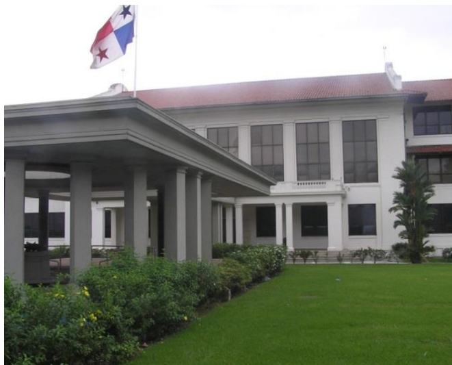
Instalaciones Centro de entrenamiento Ascanio Arosemena Panamá.
